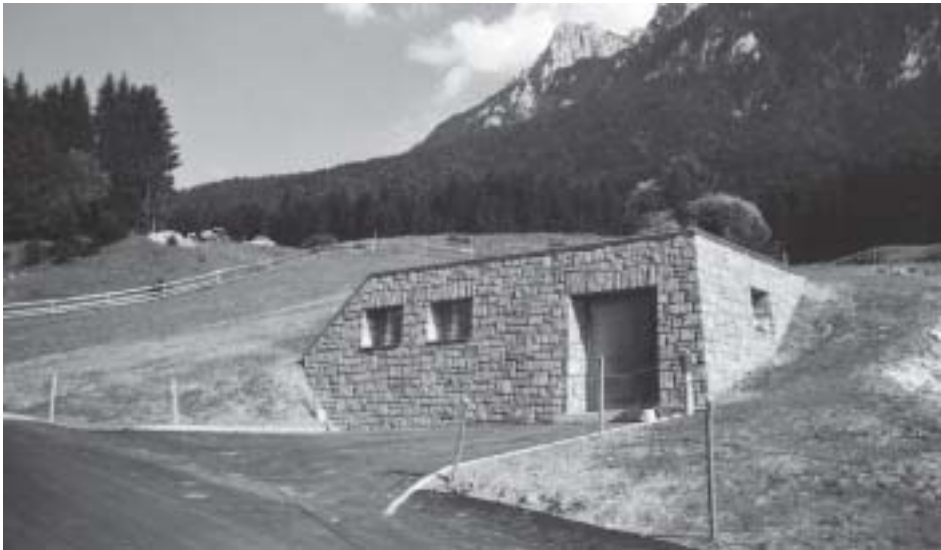
Der neu errichtete Hochbehälter auf der Feldberger Frei (2001).
