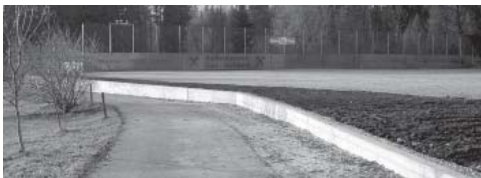
Die Stützmauer am Sportplatz schafft mehr Platz.
