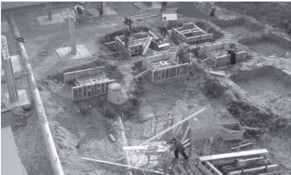
Ein Blick auf die Fundamente und die Abflussleitungen.
