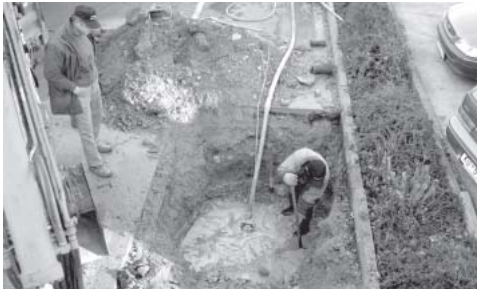
Der Bauhof bei der Behebung eines Rohrbruchs.
