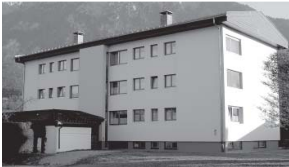
Das Lehrerwohnhaus wurde mit einem beträchtlichen Aufwand generalsaniert.
