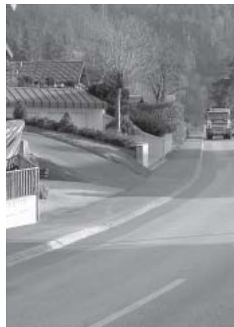
Blick auf den neuen Gehsteig in Kaiseraufstieg.
