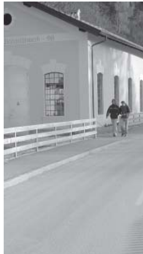
Der Gehsteig in Kaiseraufstieg E-Werk-Gebäude.
