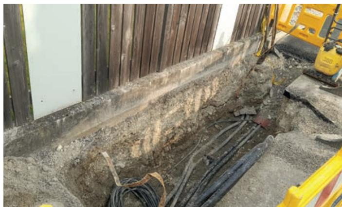
Das Straßenbeleuchtungskabel für den neuen Beleuchtungsmast am Roßbachweg wurde im Zuge der Grabung der TINETZ mitverlegt.
